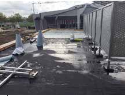
Het vegetatiedak in eerste opbouw.
